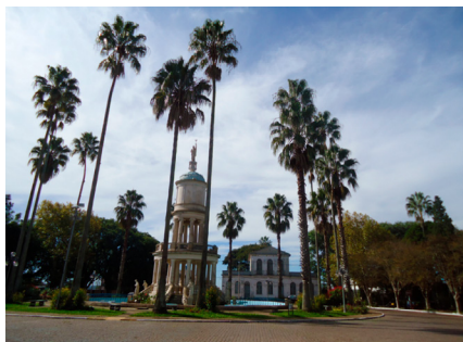
Figura 1: Château d'Eau e Paço Municipal antes da restauração
